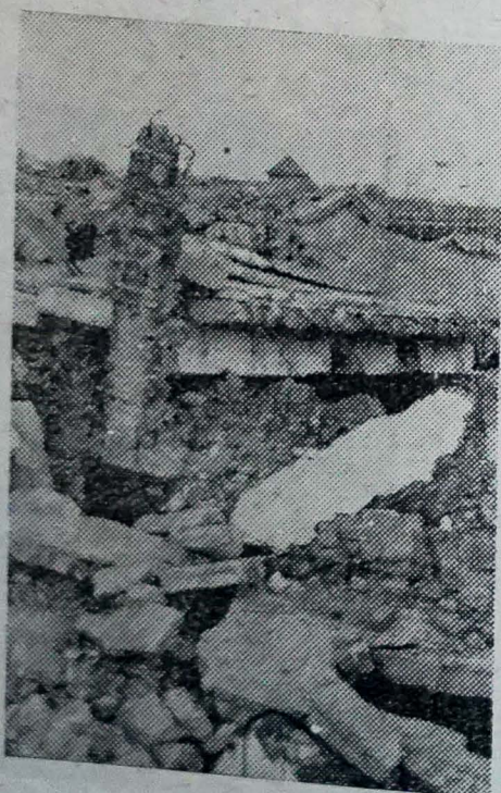
Gruzy zburzonego krematorium w Oświęcimiu
