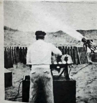
Silnik wyrzuca snop płomieni z czterech cylindrów. Przewód jest chłodzony płynnym tlenem o temperaturze - 360 stopni Fahrenhita
