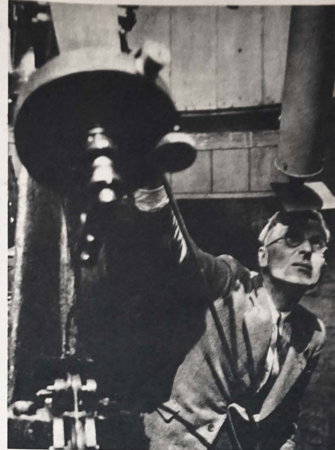
Od roku 1873, w najciemniejsze dni pochmurne, aparaty Greenwich codziennie fotografowały słońce. Aparat na zdjęciu jest wyposażony w szkło powiększające, umożliwiające robienie zdjęć o średnicy 8 cali
