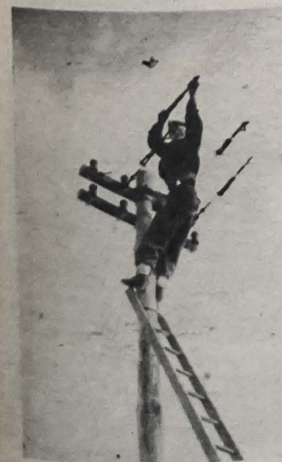
Zakładanie linii telefonicznej
