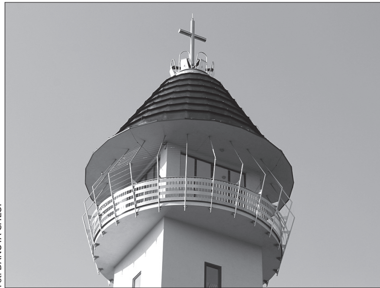
Na wieży kościoła umieszczona została korona pozłacana 24-karatowym złotem.
