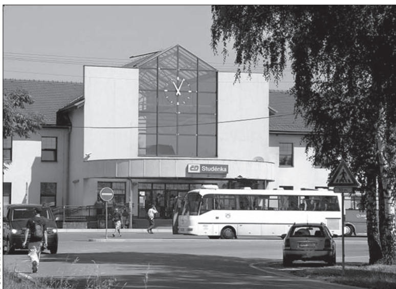
Ruch na stacji kolejowej w Studence, w środę sparaliżowany przez wypadek, powoli wraca do normy.
