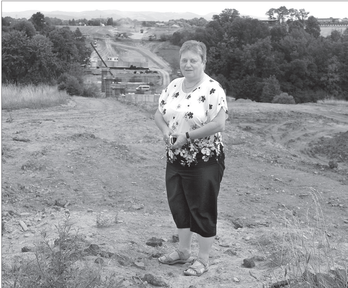
Irena Krzyżanek koło placu budowy nowej drogi I/11 w Trzyciu-Nieborach.
