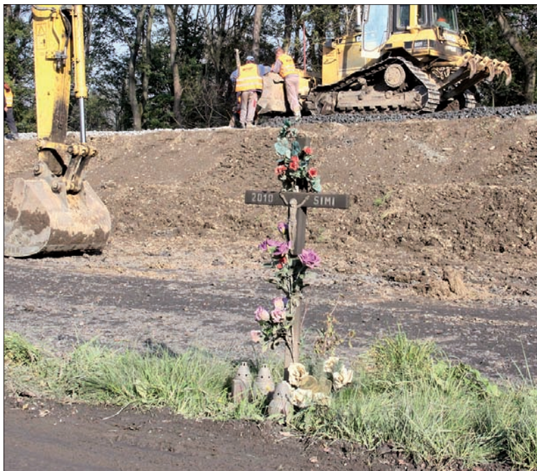
Krzyż na placu budowy w Łąkach przypomina o śmierci młodej kobiety.
