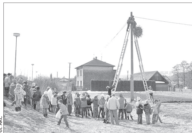
Fot. ARC Montaż bocianiego gniazda w gródeckiej osadzie Ząptocie.
