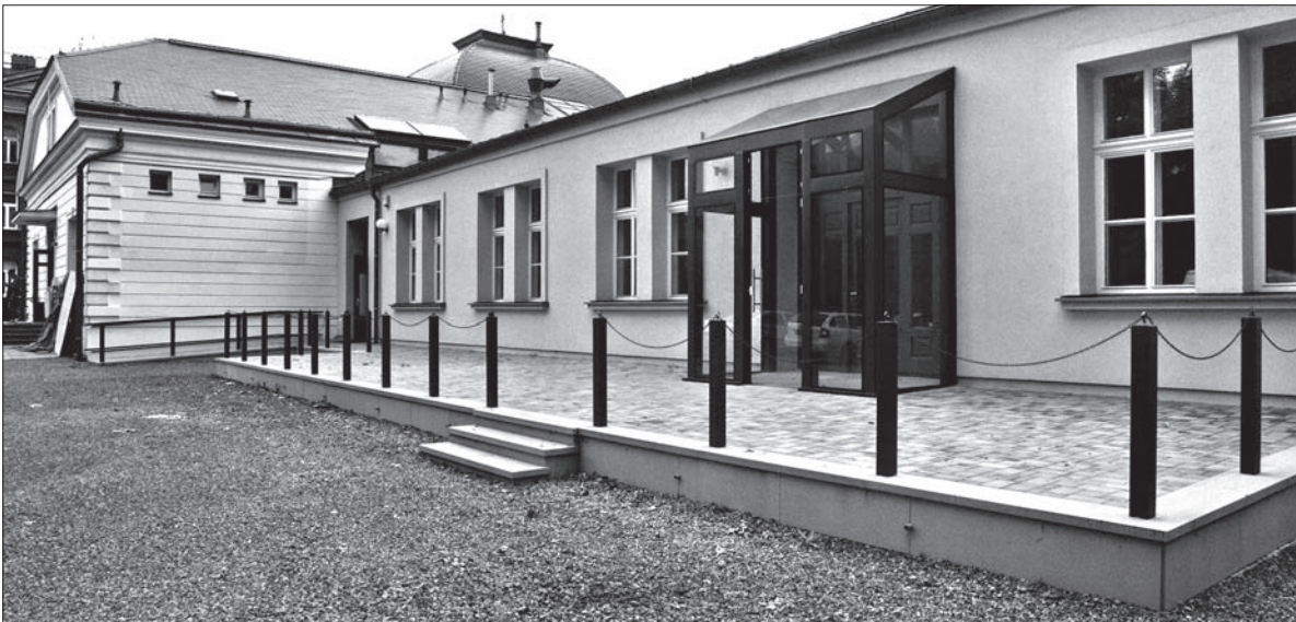
Remont „Strzelnicy” dobiegł końca.
