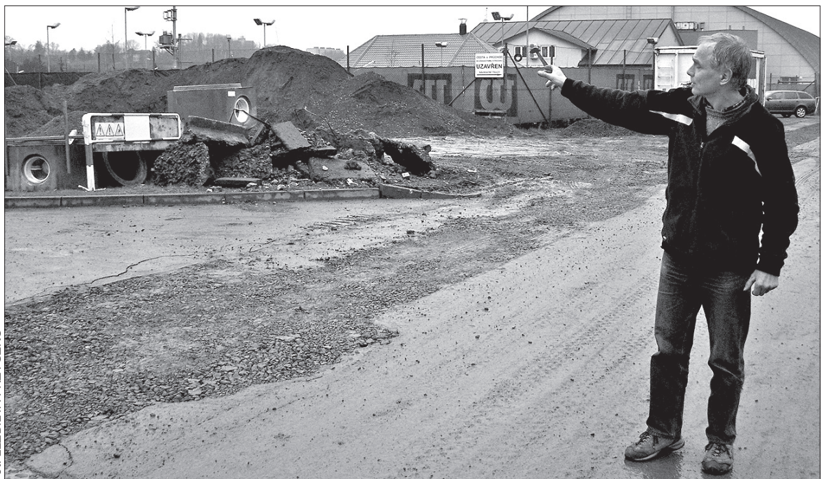
Bogusław Raszka pokazuje miejsce, w którym w sierpniu rozpocznie się budowa nowej drogi dojazdowej do torów kolejowych i drogi głównej na Trzyniec oraz Bystrzycę.
