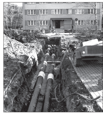
W 2010 roku kontynuowana będzie budowa ciepłociągu.
