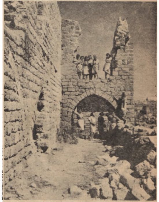
Na wycieczce w Tyberiadzie.
