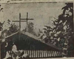
Fotografia części dachu kaplicy przy Rio Correntoso i Lima.
