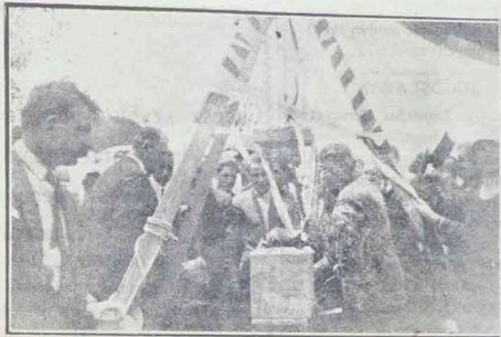
Wmurowanie Kamienia pod budowę Domu Polskiego w Llavallol
