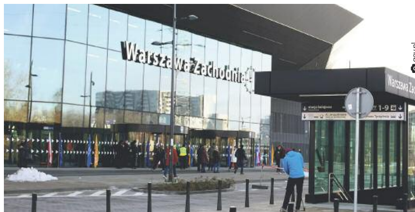
Dworzec PKP Warszawa Zachodnia został gruntownie przebudowany i zmodernizowany
