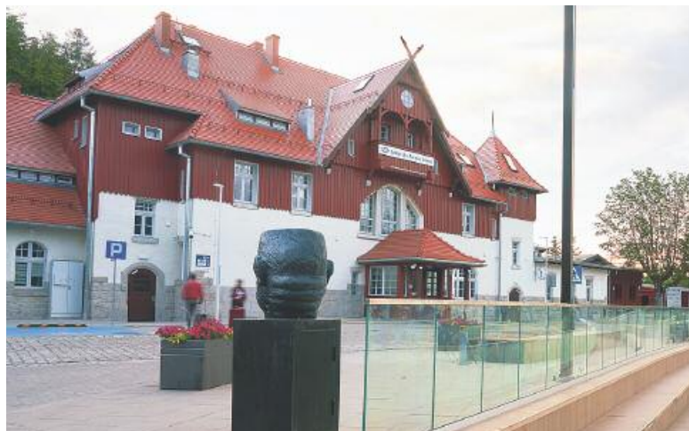
Dworzec w Szklarskiej Porębie
