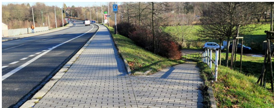
[ 15 ] Zejście dla pieszych do ulicy U Strużki
