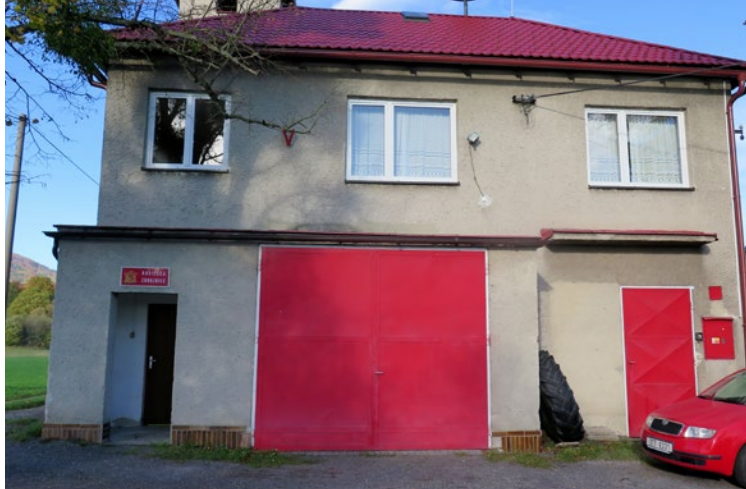
[ 4 ] Remiza straży pożarnej
