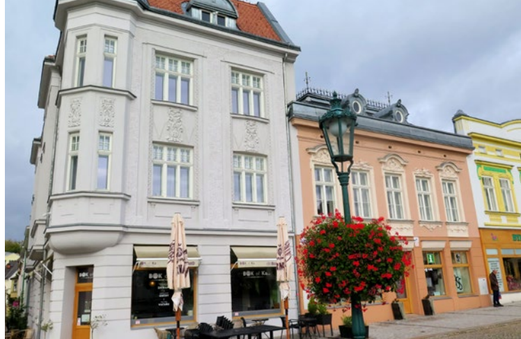
[ 12 ] Przyrynkowa kamienica oddana niedawno do użytku po gruntownym remoncie
