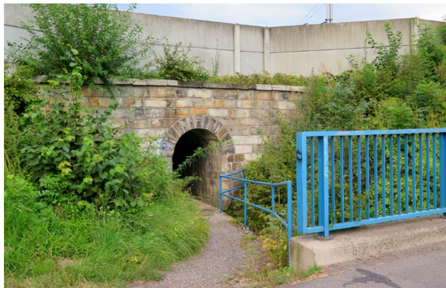
[ 49 ] Kanał pod torami kolejowymi, którym można swobodnie przejść
