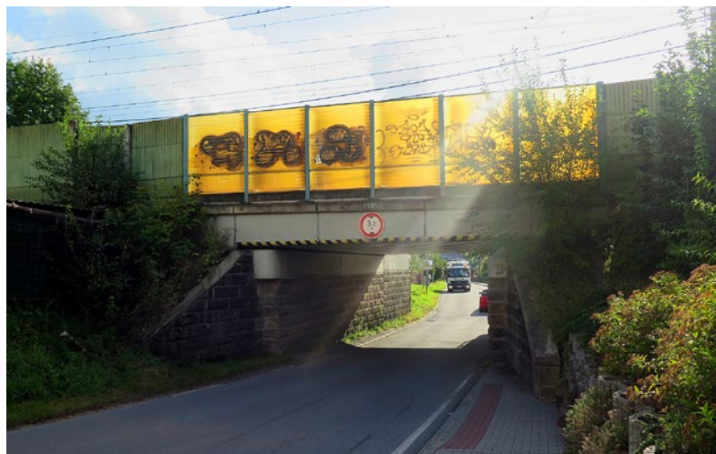
[ 23 ] Przejście pod torami
