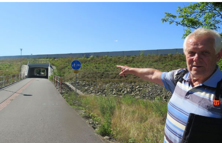
[ 14 ] Podziemny przejazd drożki pieszo-rowerowej pod obwodnicą
