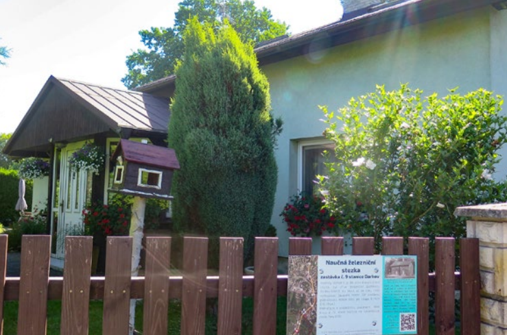
[ 7 ] Dom rodzinny który był dawniej stacją kolejową
