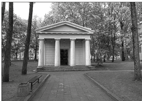
Zachowana kaplica cmentarna z roku 1819 na byłym cmentarzu reformowanym (kalwińskim)
