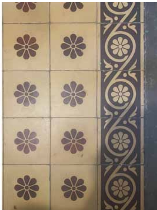
Rys. 8. Płytki na klatce schodowej (prawdopodobnie wykonane przez firmę Barta & Tichy)
