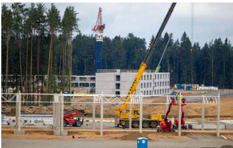
Budowa poligonu w Rudnikach, stan w lipcu br. Fot. Julius Kalinskas, ELTA
