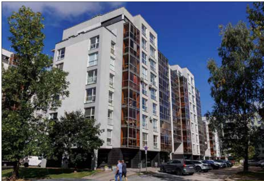
Nowe inwestycje mieszkaniowe w Wilnie cieszą się dużym zainteresowaniem — część lokali sprzedaje się jeszcze przed zakończeniem budowy
