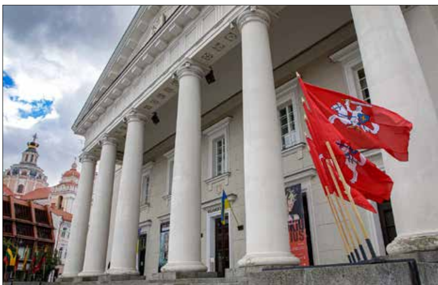
Zakończenie remontu Ratusza zaplanowano na trzeci kwartał 2026 r. Fot. Marian Paluszkiewicz
