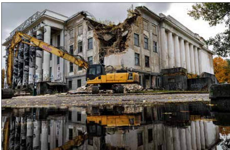
Narodowa Sala Koncertowa powstaje w miejscu wyburzonego w 2019 r. Pałacu Związków Zawodowych
