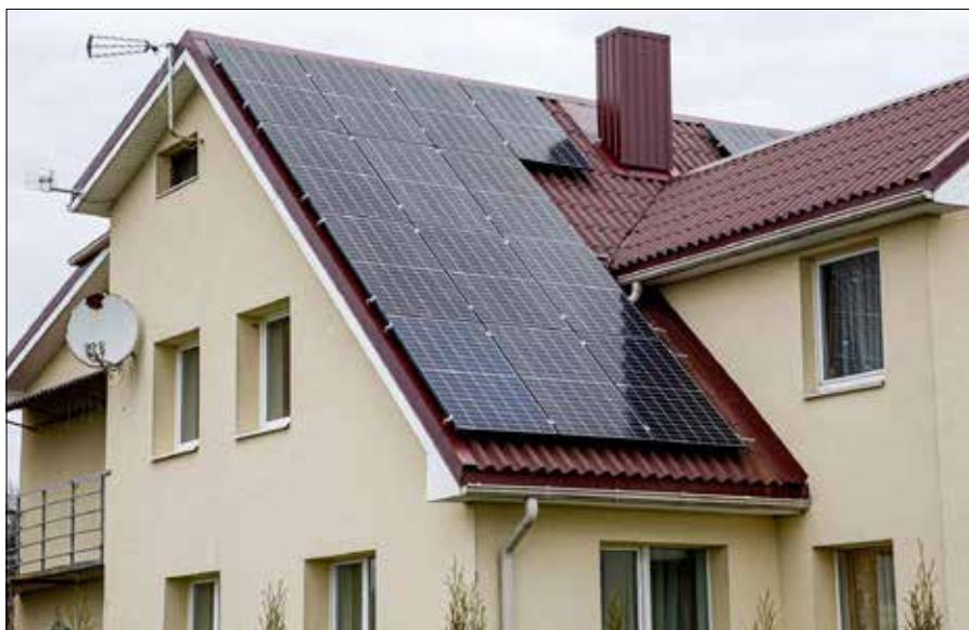
Na dachach domów jednorodzinnych na Litwie działa już około 100 tys. instalacji fotowoltaicznych Fot. Marian Paluszkiewicz
