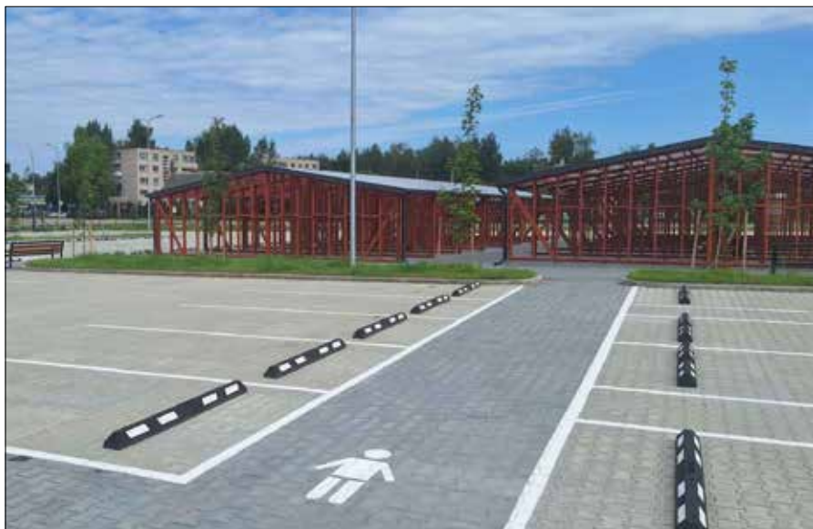
Do połowy 2025 r. przeprowadzono gruntową rekonstrukcję targowiska w Rudominie
