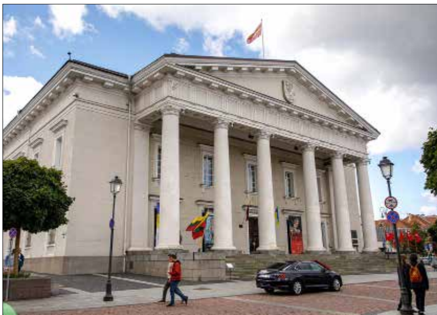
Remont stołecznego Ratusza potrwa do maja przyszłego roku
