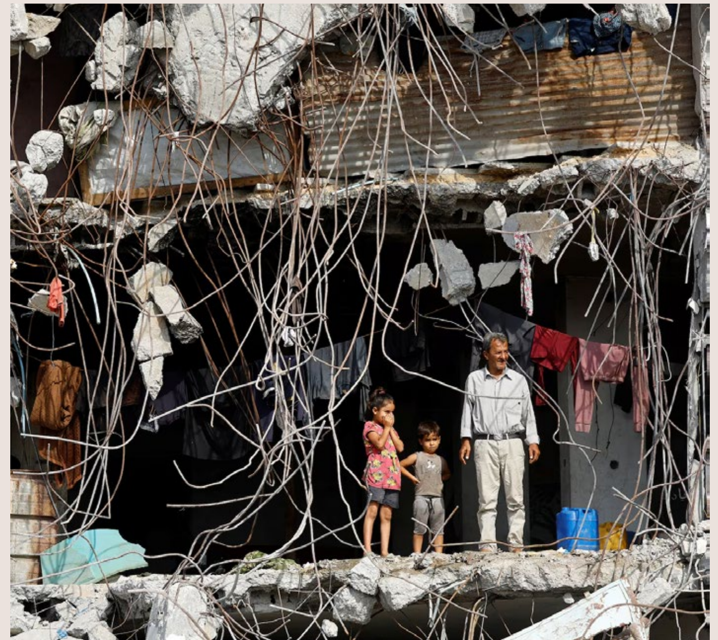
Palestyński mężczyzna i dzieci stoją przy mocno zniszczonym budynku otoczonym odsłoniętymi prętami zbrojenio- wymi i gruzem w mieście Gaza - reuters.com
