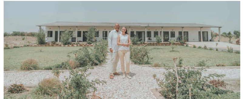
• Courtney i Monika przed ośrodkiem szkoleniowym, który wybudowali na obrzeżach Kabwe.
