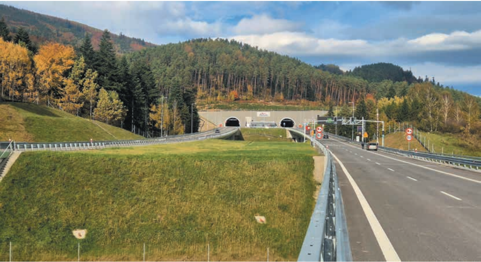
● Obejście Węgierskiej Górki to jedna z najbardziej malowniczych i imponujących dróg w Polsce. Prowadzi wysoko nad doliną Soły, u podnóża Beskidu Śląskiego. Fot. TOMASZ WOLFF
