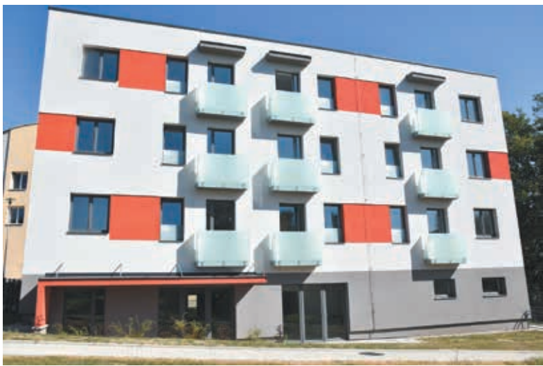
Nowy budynek czeka już na lokatorów. Fot. DANUTA CHLUP
