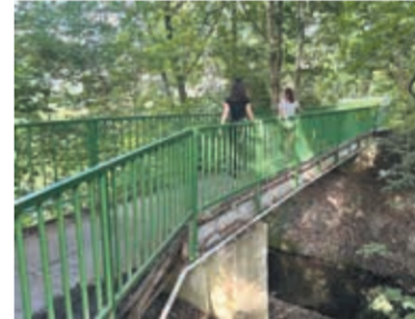
Po remoncie kładka zostanie poszerzona do szerokości 2 metrów.
