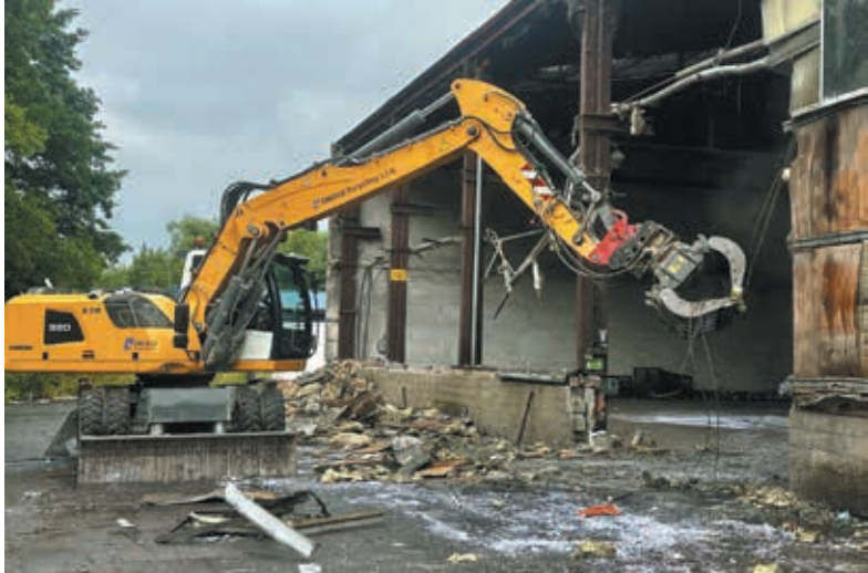
• Rozbiórka starej sortowni rozpoczęła się w poniedziałek. Ma potrwać od końca lipca. Fot. mat. pras.
