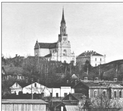
Przed kościołem św. Kazimierza – budynek należący do Kazimierza Rastenisa, który został przekazany Szkole Powstaniej nr 1 im. Tadeusza Kościuszki
