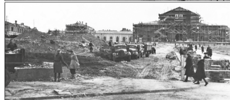
Znaczne fragmenty dworca ocalały – 1948; Prace przy odbudowie, 1950
