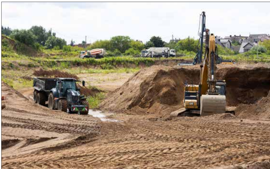
■ W Wilnie po rocznej przerwie wznowiono budowę stadionu narodowego Fot. Dainius Labutis, ELTA
