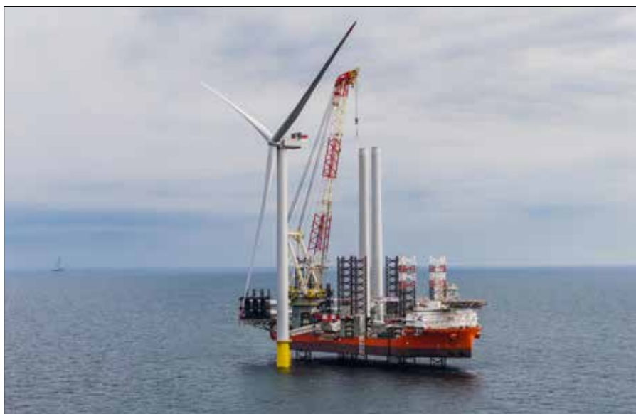
■ Prace instalacyjne turbin prowadzi mierzący 160 m statek typu jack-up
