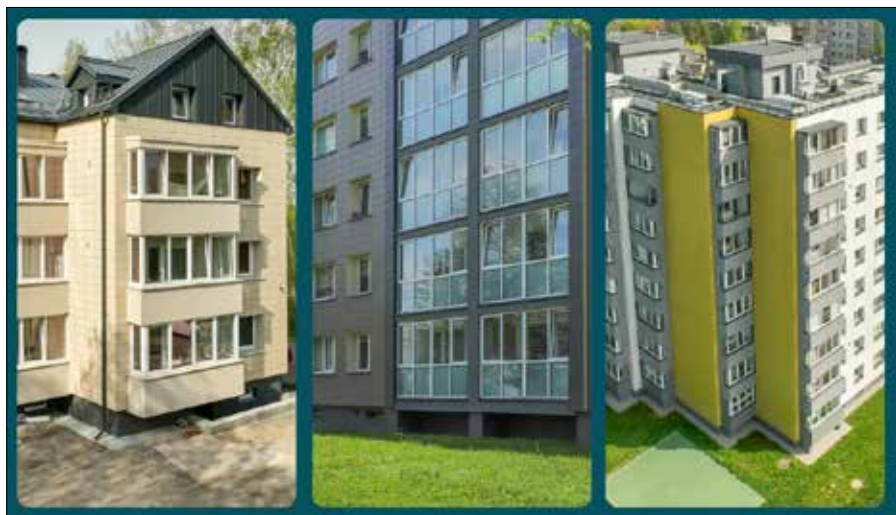
■ Budynki mieszkalne po renowacji Fot. z archiwum APVA
