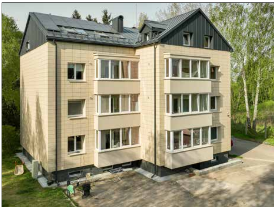
■ Odnowiony blok wielomieszkaniowy Fot. arch. APVA
