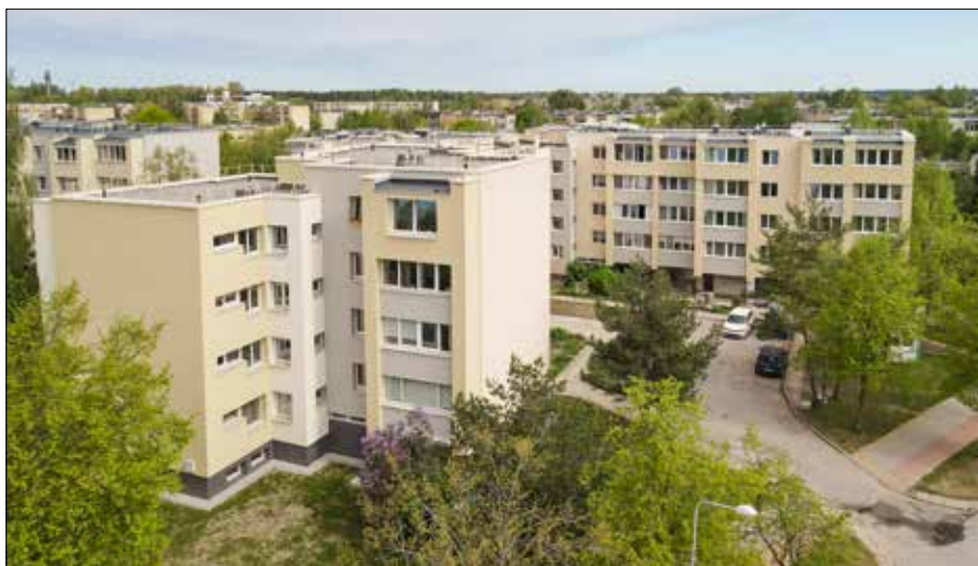
■ Budynek mieszkalny po renowacji Fot. z archiwum APVA
