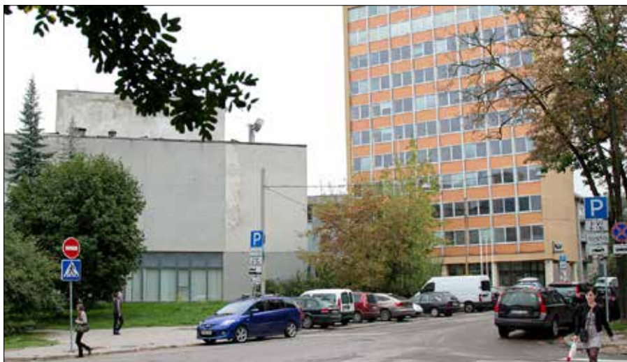
Pałac Kultury Budowlanych (po lewej) wzniesiono na fundamentach kościoła Fot. Marian Paluszkiewicz
