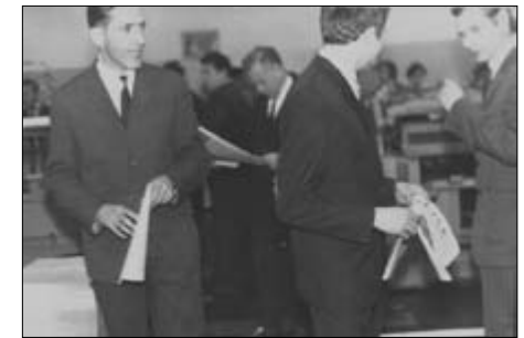
To już rok 1980. Na zdjęciu komisja, która odbierała nowo wybudowaną drukarnię w Pieszcu, w skład której wchodził przedstawiciel wykonawcy, inspektor nadzoru, przedstawiciel finansującego banku, sanepidu, związków zawodowych oraz inwestora – w płaszczu z lewej, autor. U dołu od lewej – jako kierownik Zakładu Graficznego drukarni, w której pracował
