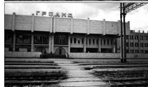
Stary Dworzec kolejowy w Grodnie (1915) i współcześnie działający, zbudowany w latach 80., w czasach jeszcze radzieckich, z całą infrastrukturą, typową dla dworców przygranicznych
