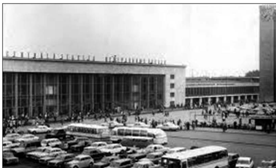
Dworzec Kolejowy w Rydze. Lata 70.
