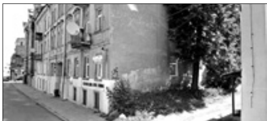
Ul. Stefańska 23, okna suteryn poniżej i na poziomie chodnika
