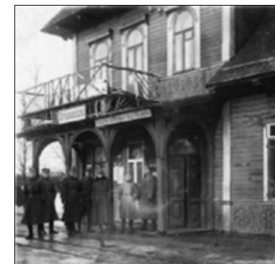
Drewniany dworzec kolejowy w Sylgudyskach (Saldutiškis), zbudowany w 1899 w stylu zakopiańskim wg projektu Stanisława Witkiewicza, 1920
