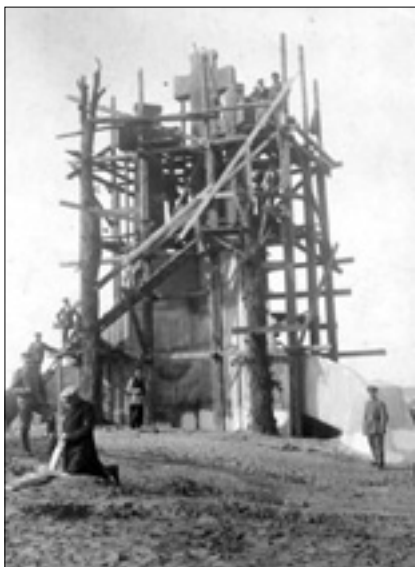
Budowa Trzech Krzyży według projektu Antoniego Wivulskiego w 1916
