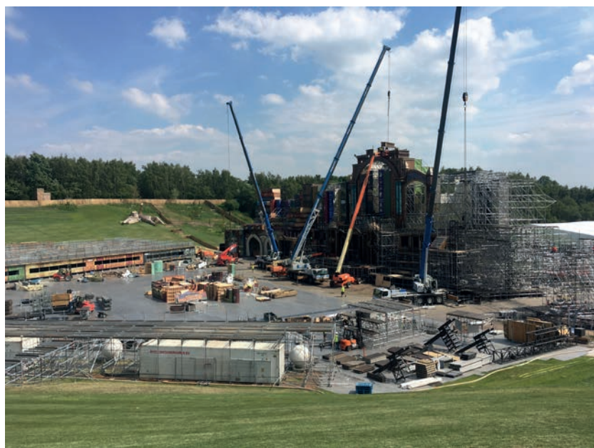
Budowa sceny głównej 2019, kolekcja prywatna
