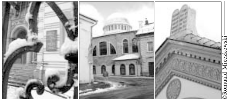
Zbudowana w 1903 synagoga na Zawalnej – od frontonu i od ul. Krupniczej
